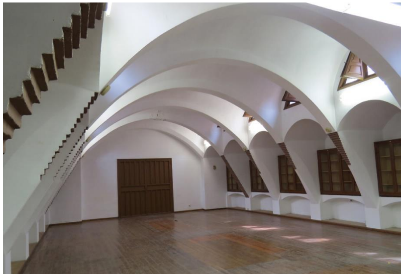
Figura 9 Arcos catenarios. Portal Gaudí (sf.)
