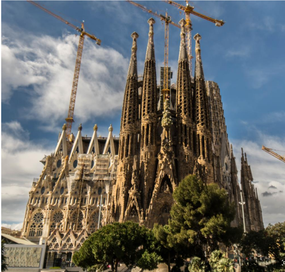
Figura 63 Fachada de la Natividad y torres campanario. Matías Romero (2018)
