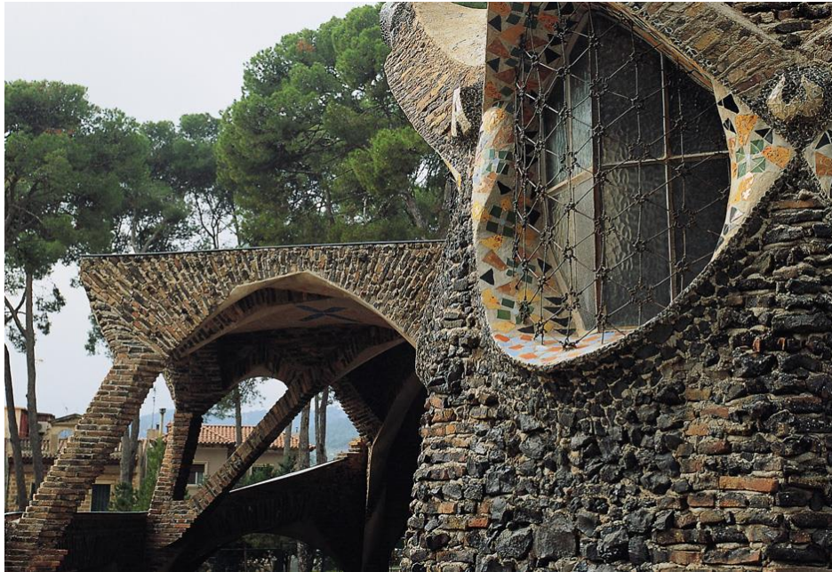
Figura 37 Ventana de hierro forjado. Portal Gaudí (sf.)
