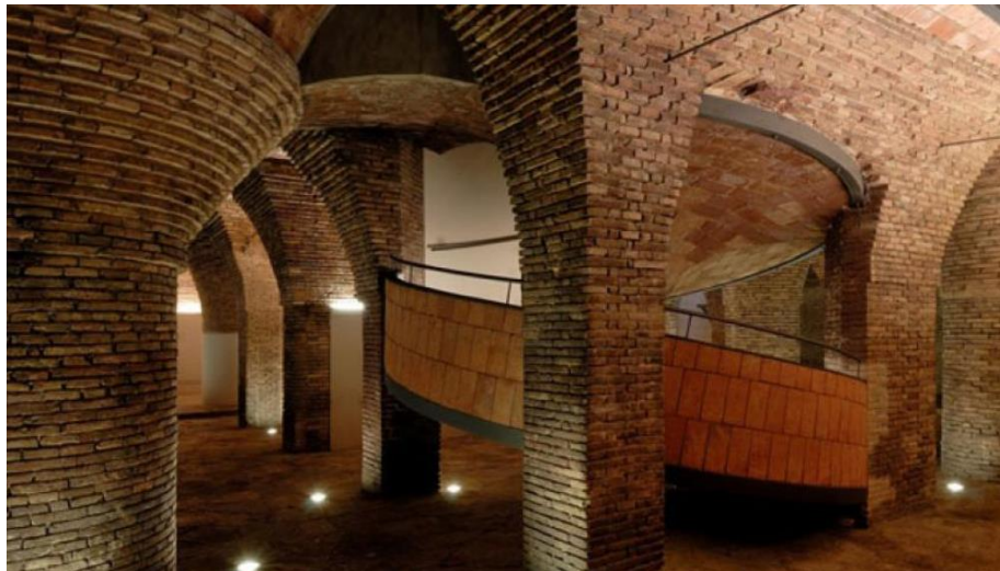
Figura 15 Rampa en forma de espiral helicoidal, situada en la planta subterránea. Monserrat Baldomá (sf.). Diputació de Barcelona
