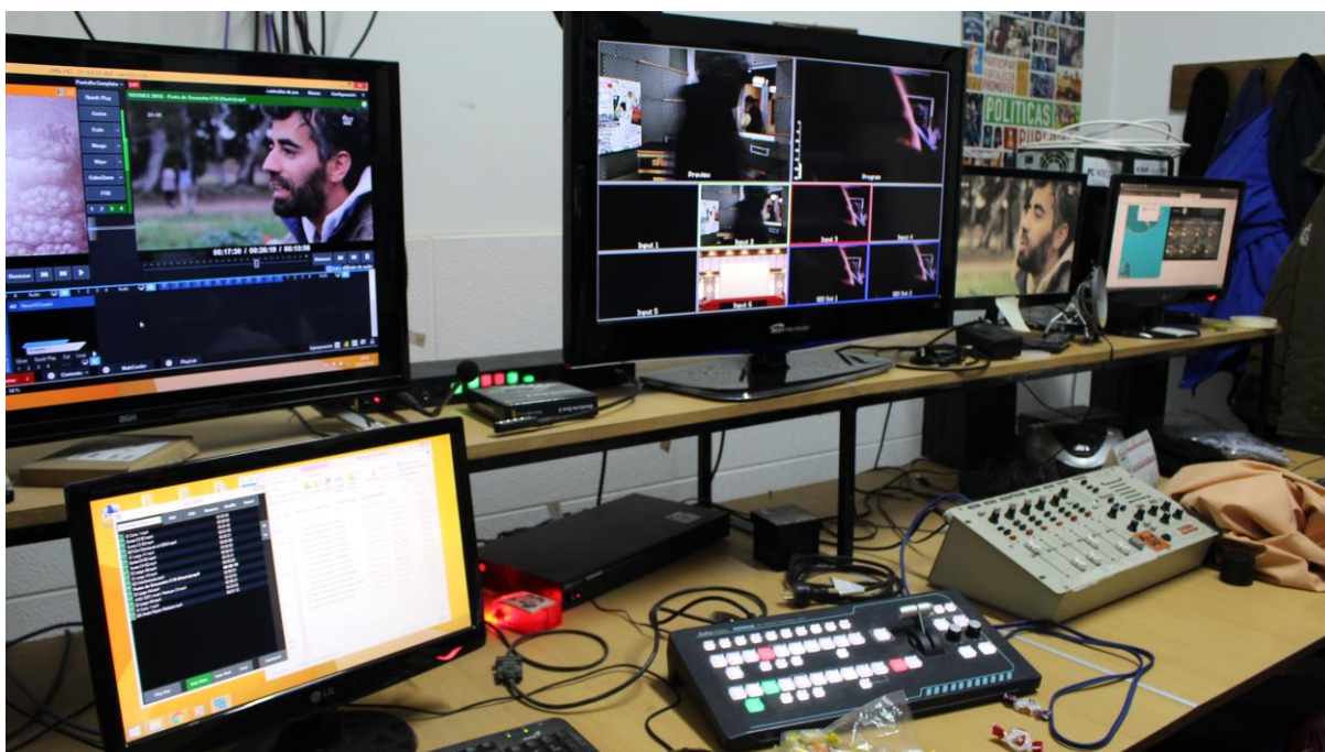
Switcher y automatizador de video en el control de ENTV.
