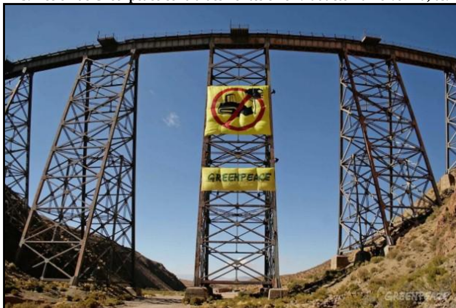
Foto N° 23. Acción de Greenpeace contra desmontes en el Viaducto La Polvorilla, 09/10/2008.
