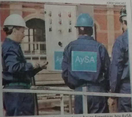
Operarios. La vieja Obras Sanitarias, luego Aguas Argentinas, hoy AySA
