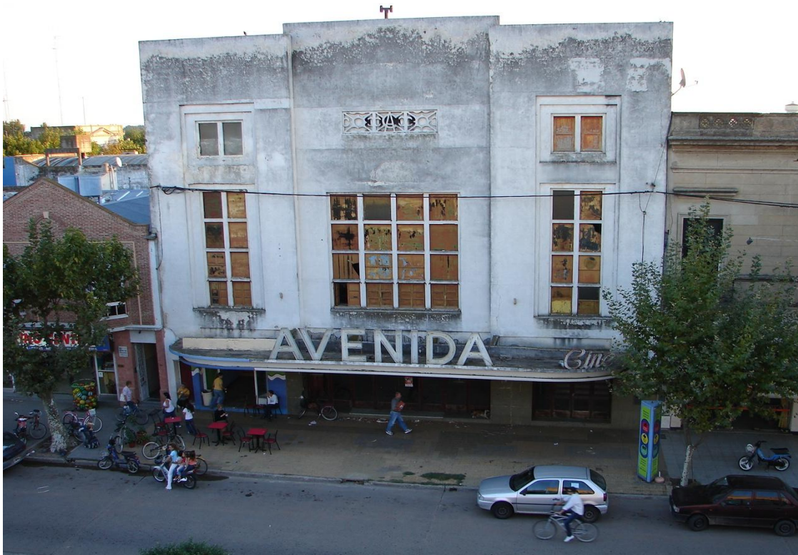
Fachada del cine Avenida en el período que permaneció cerrado.
