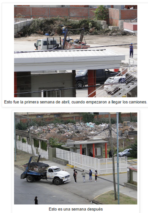
Imagen 9 20 : Fotografías del blog sobre la instalación de la segunda planta de transferencia de residuos del CEAMSE.
