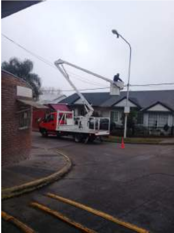
Fotos 48 y 49. Reparación y control de luminarias por reclamos. Fuente: Portal de Facebook de Junta Vecinal
