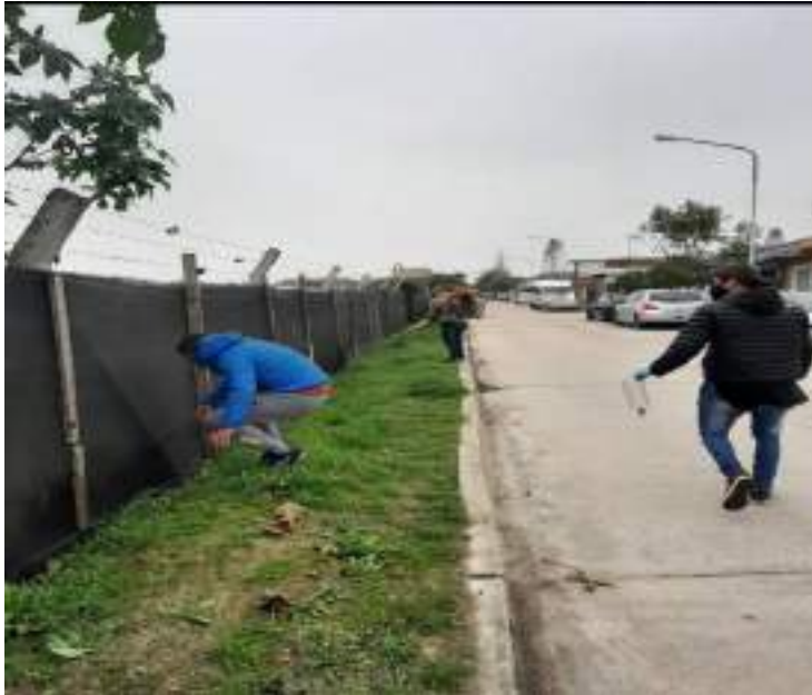
Foto 20 y 21. Muro hecho con alambrado de púas. Fuente: Portal de Facebook de Junta Vecinal Altos de Podestá.
