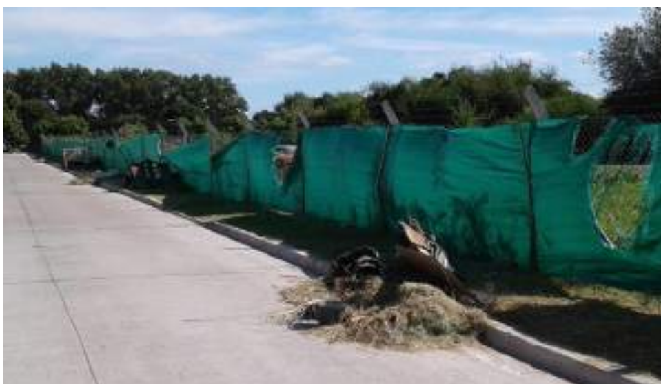
Foto 25. Rotura del alambrado en el fondo del barrio. Fuente: Portal de Facebook de Junta Vecinal Altos de Podestá.
