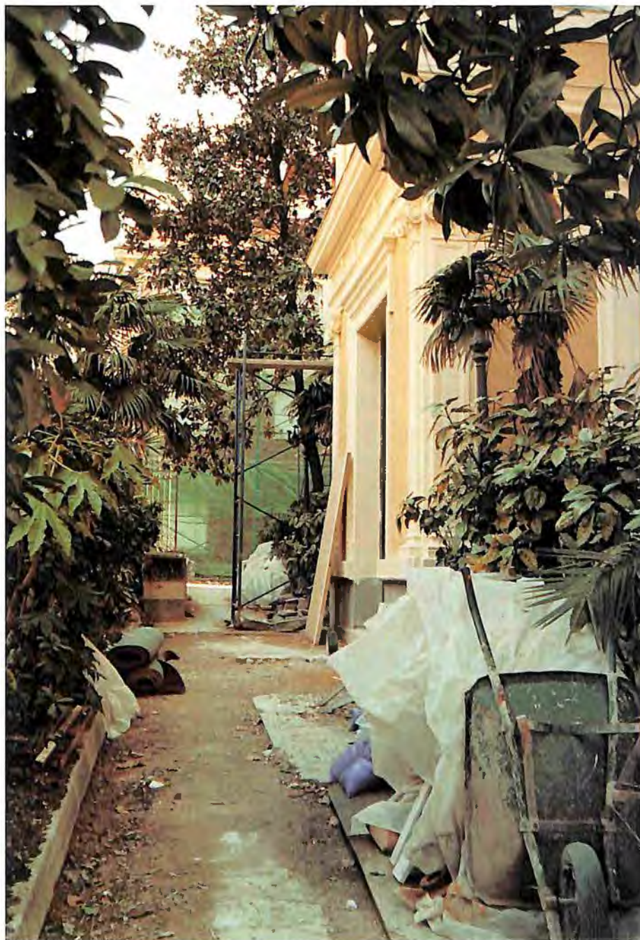
Obras de reforma en Marqués de Riscal, 16.
