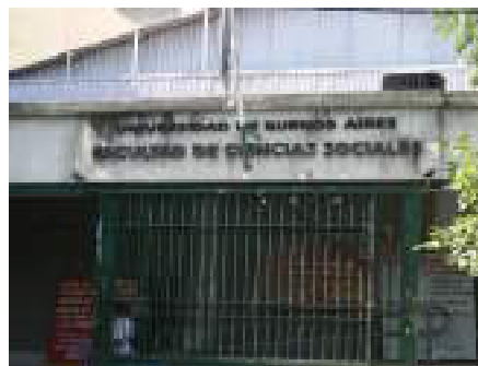
Ingreso por la calle Franklin 54
