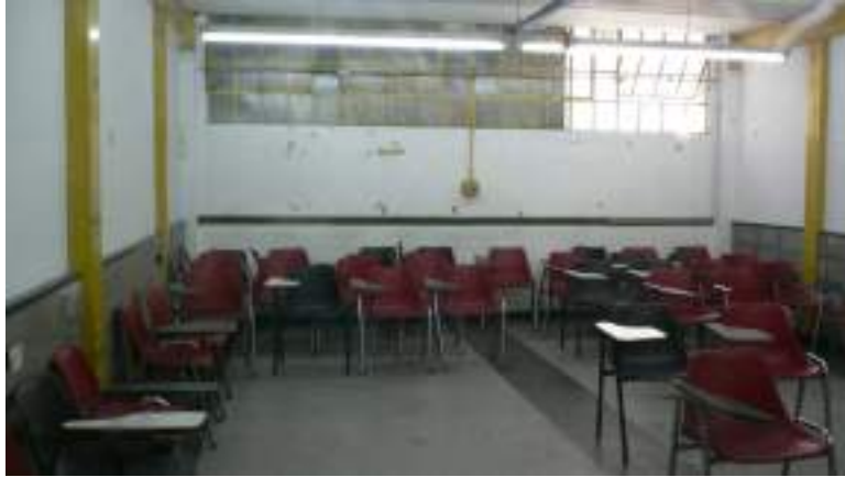
Aula en planta baja, sólo una parte de la ventana de vidrio repartido accede a un patio interno.
