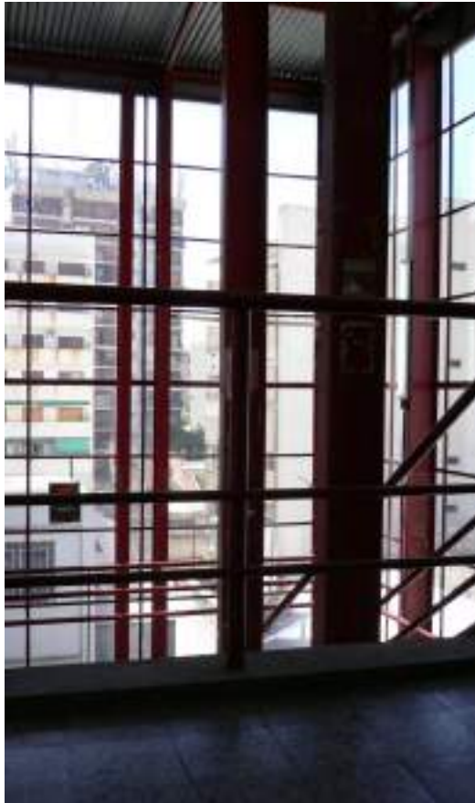
Escalera principal por el ingreso de la calle Ramos Mejía.
