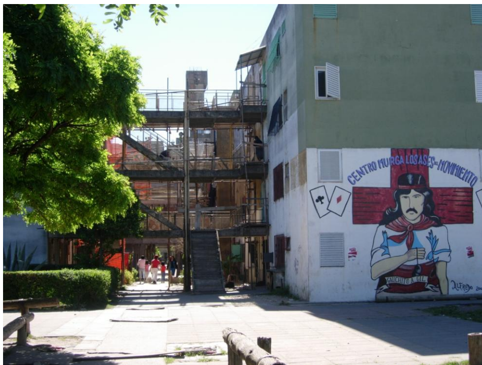
Imagen 4. Arreglos de escaleras en el Sector 32
