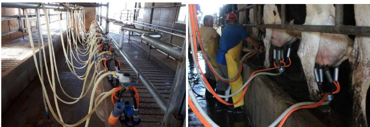
Ilustración 19 Sala de ordeño. Archivo propio
