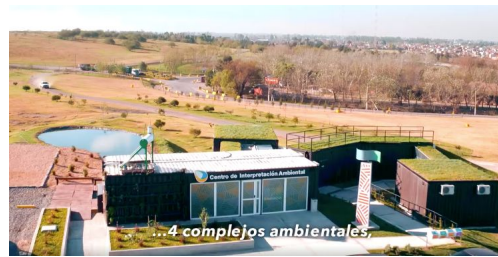
Figura 36 - Imagen aérea del Complejo Ambiental Norte III
