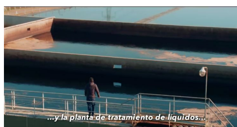
Figura 33 - Imagen de los piletones de la Planta de Líquidos Lixiviados. Todas esta imágenes pertenecen al video institucional #2 - nueva estética.
