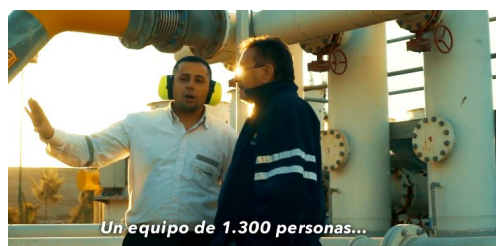
Figura 26 - Técnicos de CEAMSE dando indicaciones en Planta de Biogás
